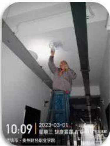
宿舍过道照明灯、安全出口灯维修
