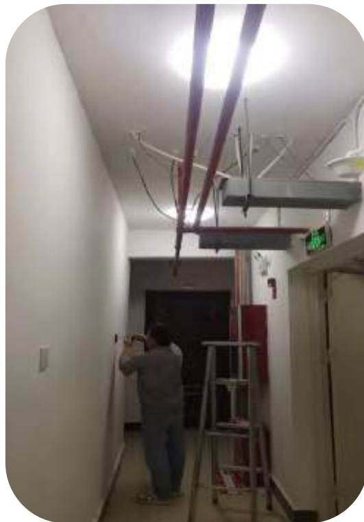
公租房照明维修
