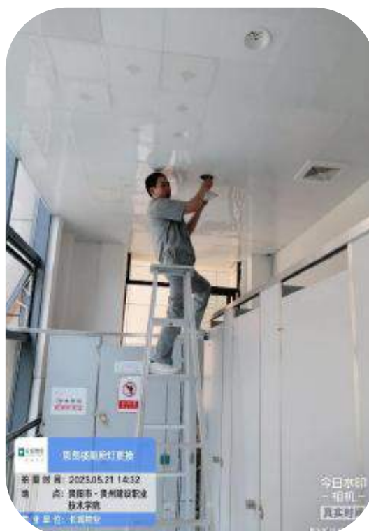
思贤楼卫生间照明更换
