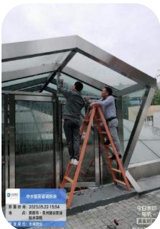
中水泵房拆除玻璃散热
