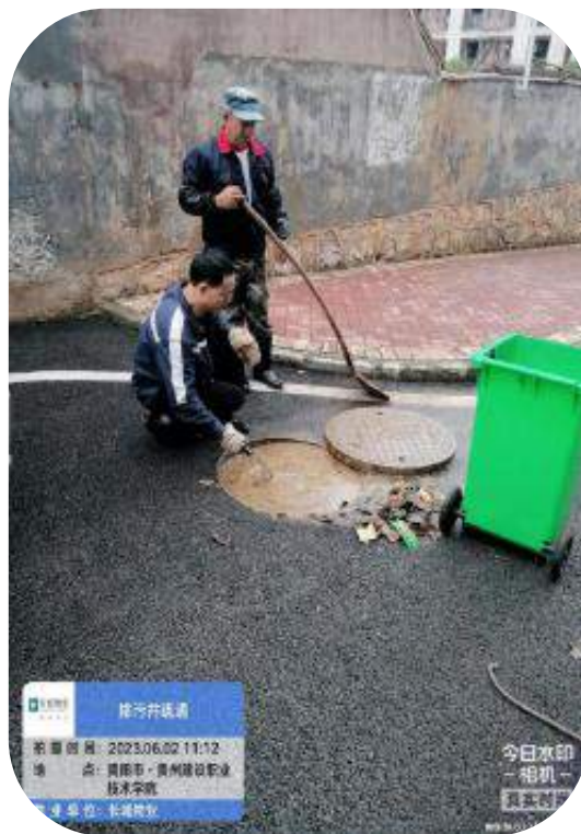
配合外单位疏通排污井
